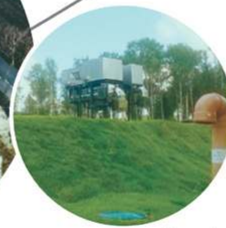
Системы Аэролайф-гидро КФЗ-300НКСАД и КФЗ-750НКСАД на железобетонном полузаглубленном РЧВ
