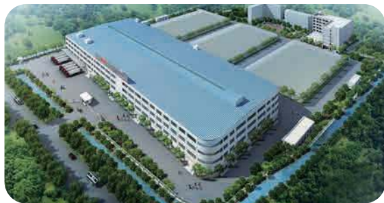
2-й завод в г. Чжуншань (7 млн внутренних блоков)
