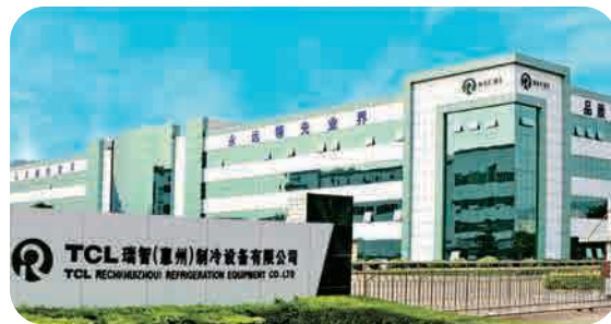
Завод СП «TCL – Reichi Compressor» (16 млн компрессоров для кондиционеров)
