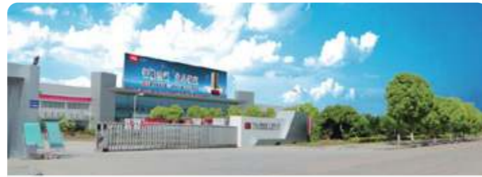
Завод в г. Ухань (5 млн. кондиционеров)
